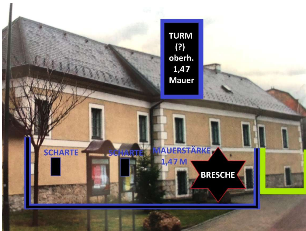
Abbildung 3: Das Feste Haus (Turmhof) bzw. die babenbergische Burg von Sollenau, heute Pfarrhof, Westwand mit Bauphasenplan und Details gem. Untersuchungsbefund Alfred Weiss. Blau-Schwarz: Romanisches Bauwerk mit Quader - Mitte 12. Jahrhundert bis um 1240/46, Grün: Gotischer Zubau mit Bruchstein
